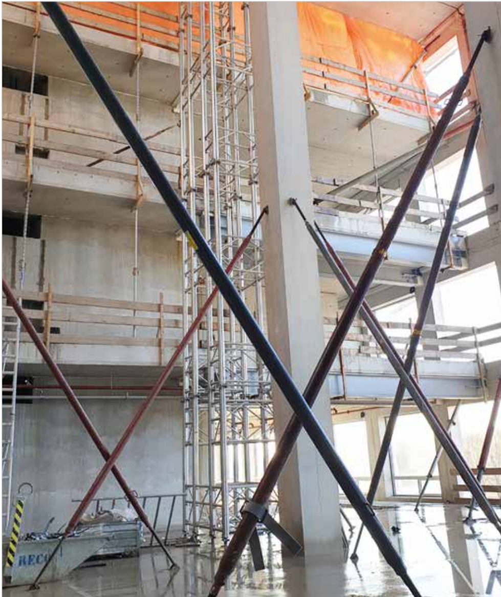
Betonfertigteile ausrichten und stützen mit Richtstreben TITAN RSK (hier Größe 8) in bis zu 7,60 m Höhe
