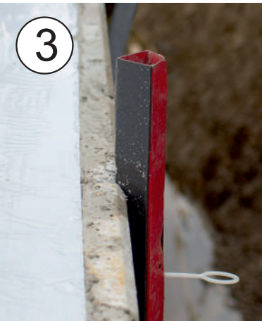
◀ FLUXX Abschalschiene in der Fuge arretieren
